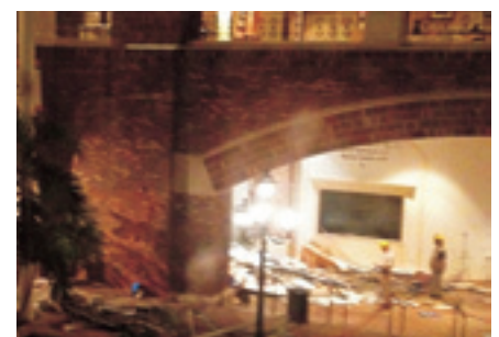
Une partie des dégâts causés par l'explosion Some of the damages caused by the explosion
